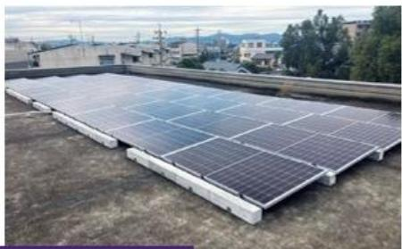
動力は計3種類の陸屋根用架台も開発済みだ。写真は置き架台
