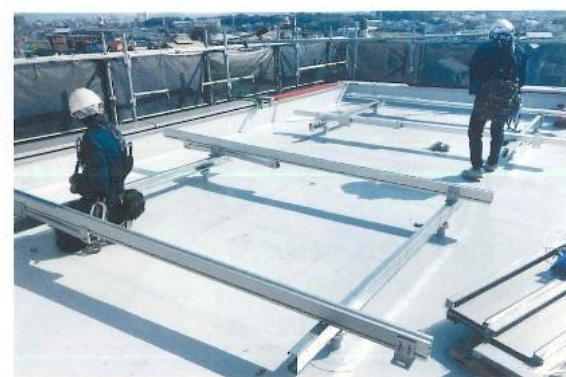
動力は架台製造だけでなく、施工にも取り組む
