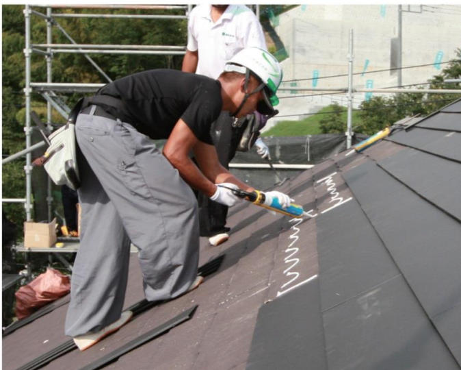
1：専用接着剤を所定の箇所に塗布します。
