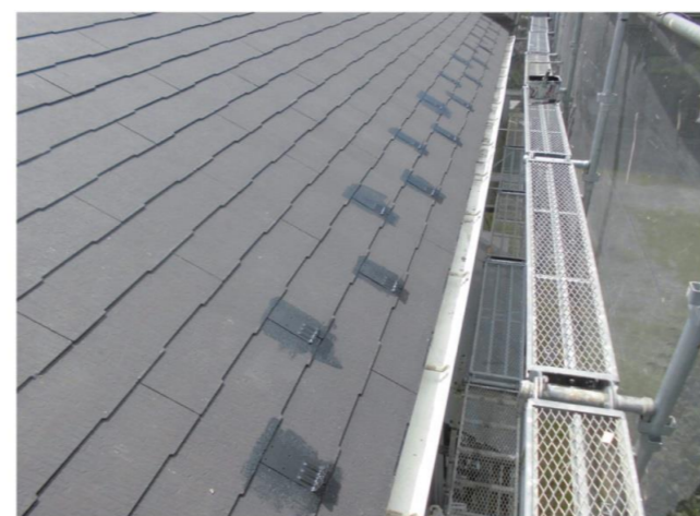
雪止め塗布状況
