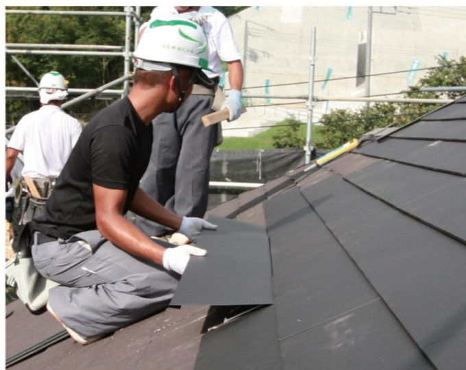
2：ウォーターチャンネルを取り付け シーガード本体を上の方のスレート 屋根の下に差し込んでいきます。
