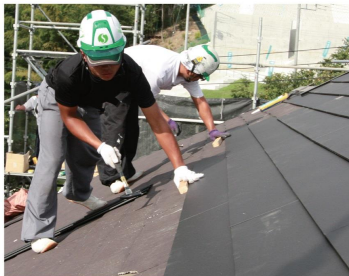
4：拍子木とハンマーで本体どおしの 通りを確認し、調節します。
